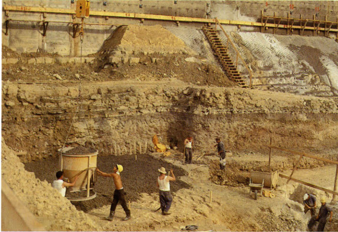
Abb. 5 Baugrube des Sanitas-Spitals im September 1970. Blick auf die Ostwand der Baugrube. Deutlich sind die flach gelagerten Molasseschichten zu erkennen. Direkt über dem dunklen Mergelhorizont liegt, scharf abgegrenzt, die 20 – 30 cm mächtige Stinkkalkschicht. Darüber folgt eine etwa 1,5 m mächtige, gut geschichtete Sandsteinbank. Noch etwas höher sind Mergel und Mergelsandsteinbänke in horizontaler Lagerung sichtbar.
