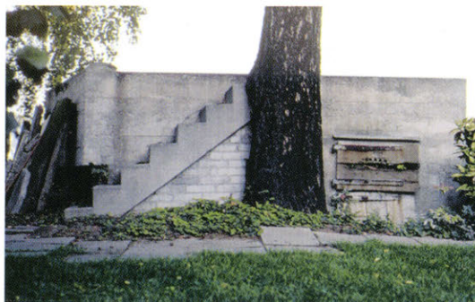
Die einzige bekannte Aufnahme des Mlg-Standes A 4822, Seestr. 119, im Jahr 1989. Er behielt seine originale zweiteilige Holztüre bis zum Abbruch 1992.
