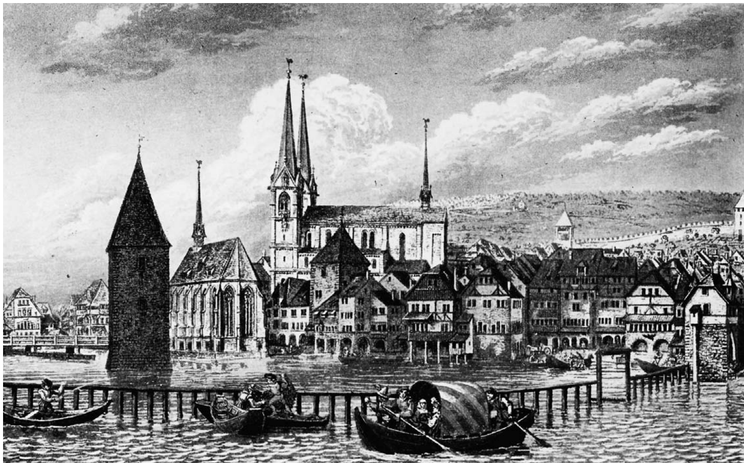
Der Hottingerturm – direkt vor dem Grossmünster
