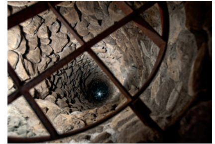
Schacht des Sodbrunnens, 17. Jahrhundert, Sanatorium Kilchberg
