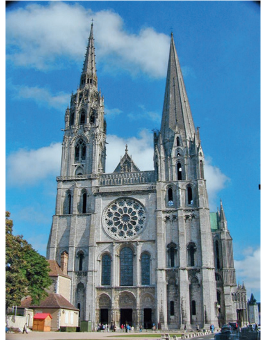
21 Westfassade der Kathedrale.
