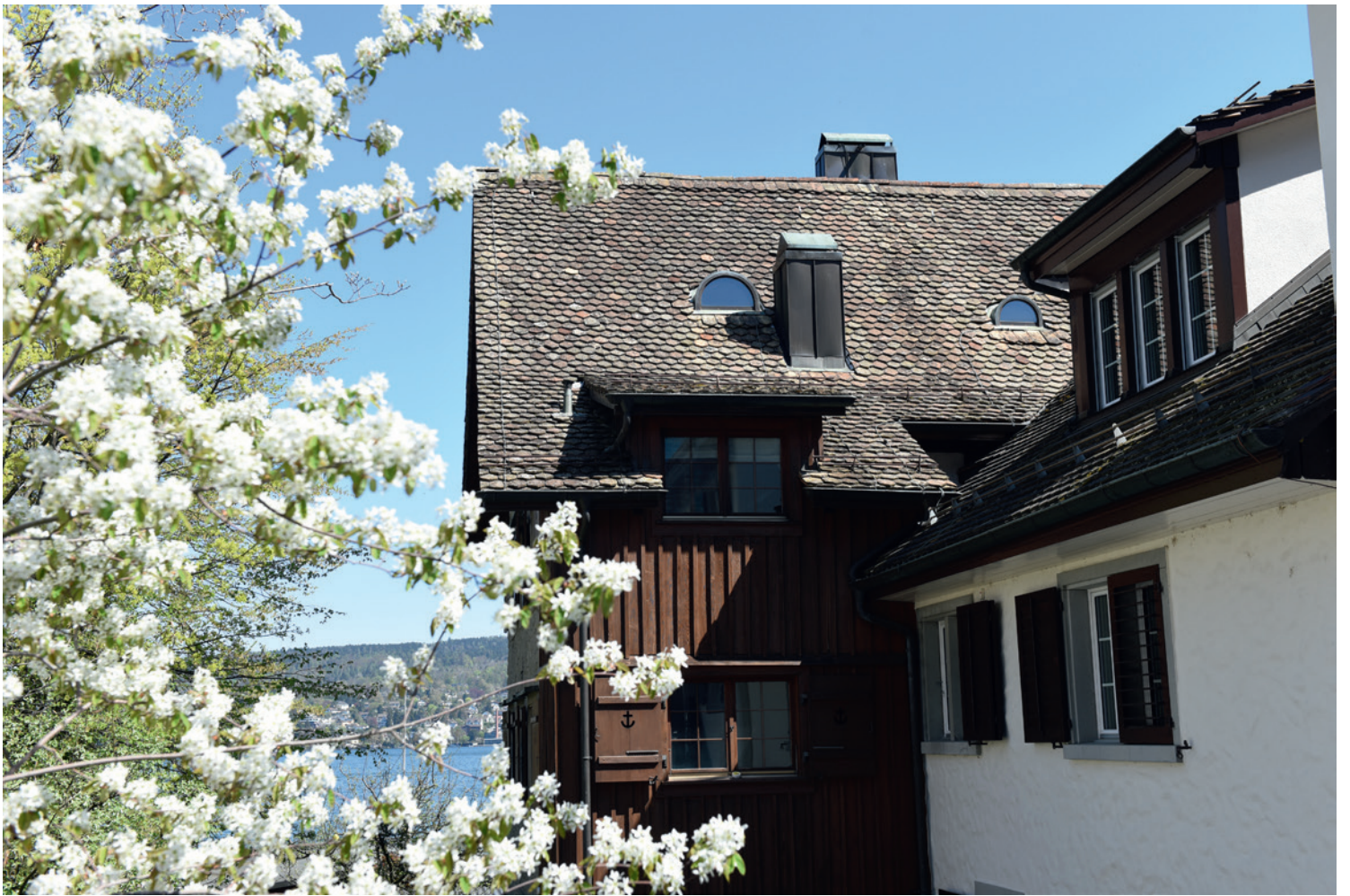
Seeseitiger Wohnhausanbau Seestrasse 217, 2018.
