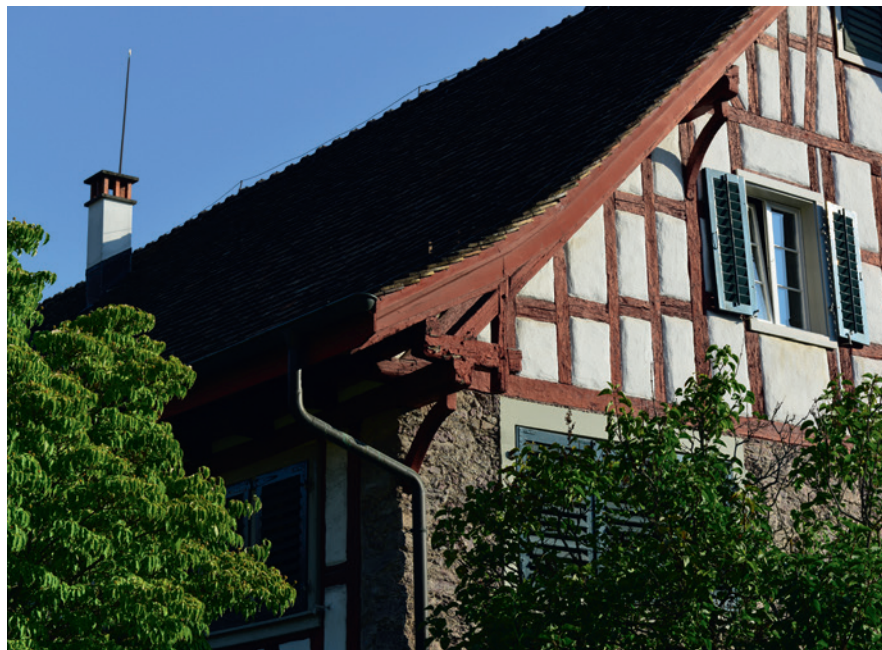
Vordachkonstruktion mit «Zürivieri».
