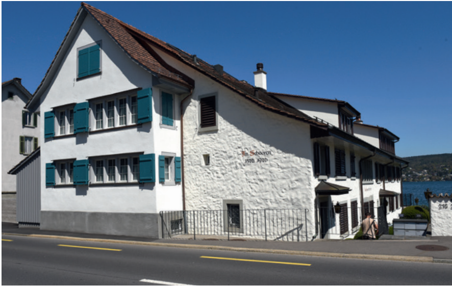
Links: Strassenseitige Giebelfassade, 2018. Links der Wohnhausanbau Seestrasse 213.
