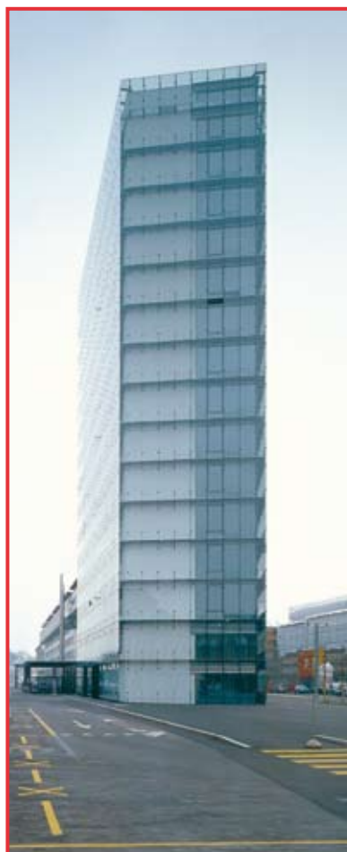
Gesunde Arbeitsplätze im Büroturm auf dem Areal «Gare de Neuchâtel» (NE-001-ECO).
