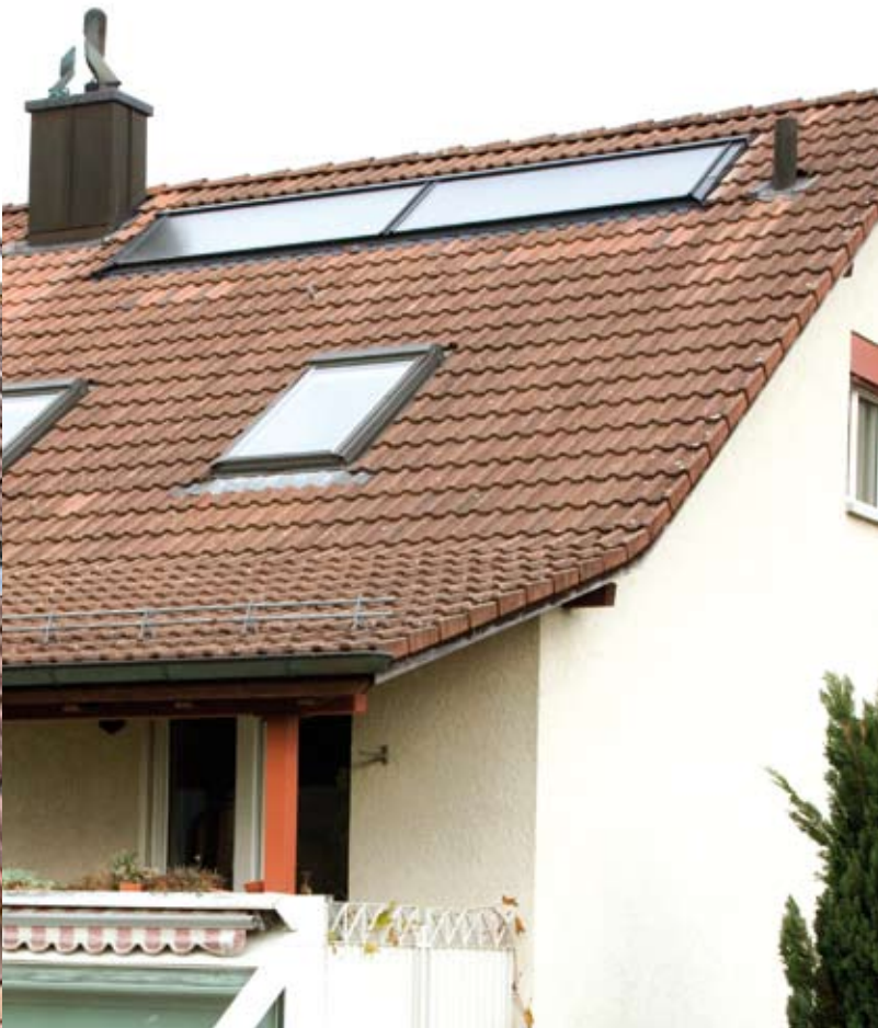
17.00 Uhr Nach nur einem Tag ist die beinahe wartungsfreie Solaranlage für Warmwasser mit dem Speicher montiert.
