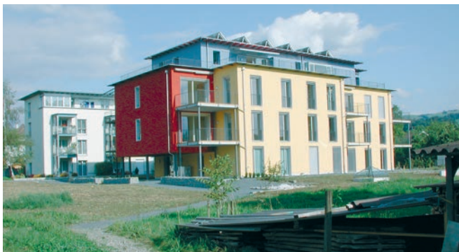
47 m 2 Sonnenkollektoren auf Mehrfamilienhaus nach Minergie-Standard in Baar ZG.
