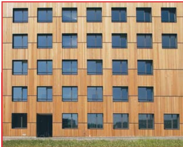
**Die Stahlblechschürzen zwischen den Fenstern verhindern im Brandfall die Ausbreitung des Feuers in der Hinterlüftung wie auch an der Oberfläche der Fassade über mehrere Geschosse.**
