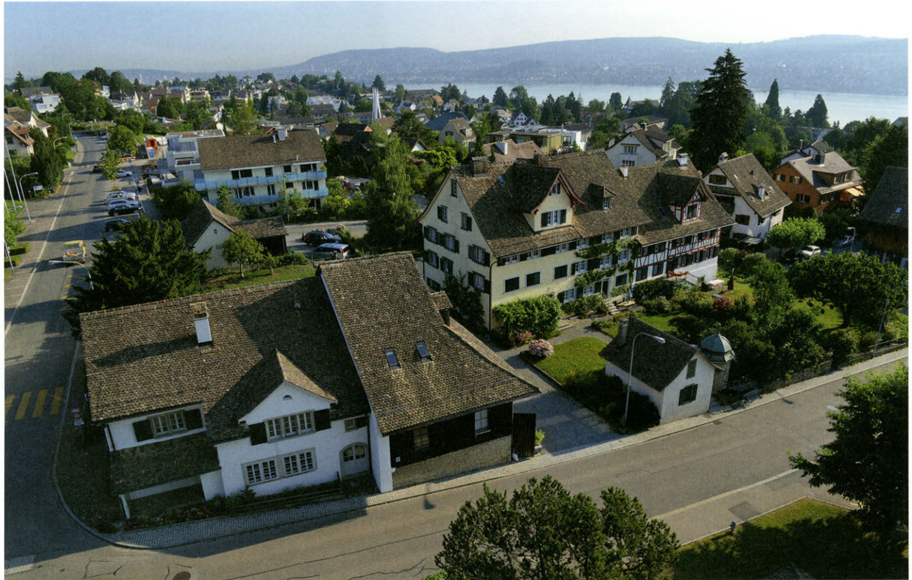
(Abb. 21) Blick vom Kirchturm auf das Sigristenhaus mit der angebauten Trotte, 2015
