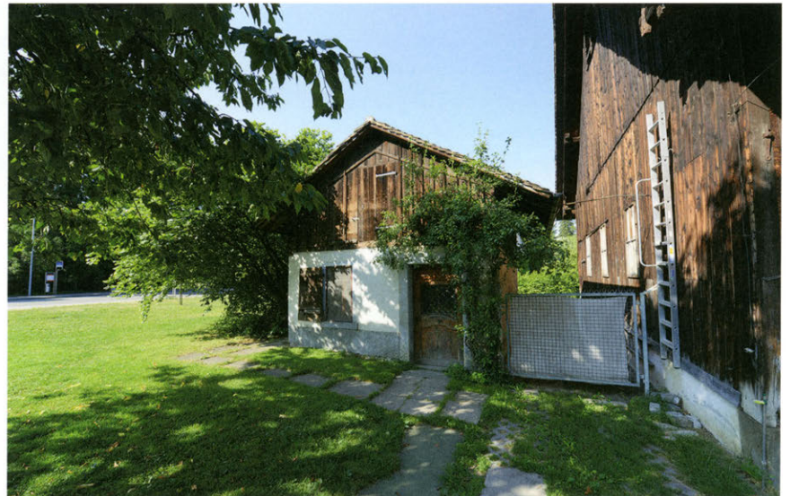
(Abb. 51) Waschhaus von Südosten, 2015
