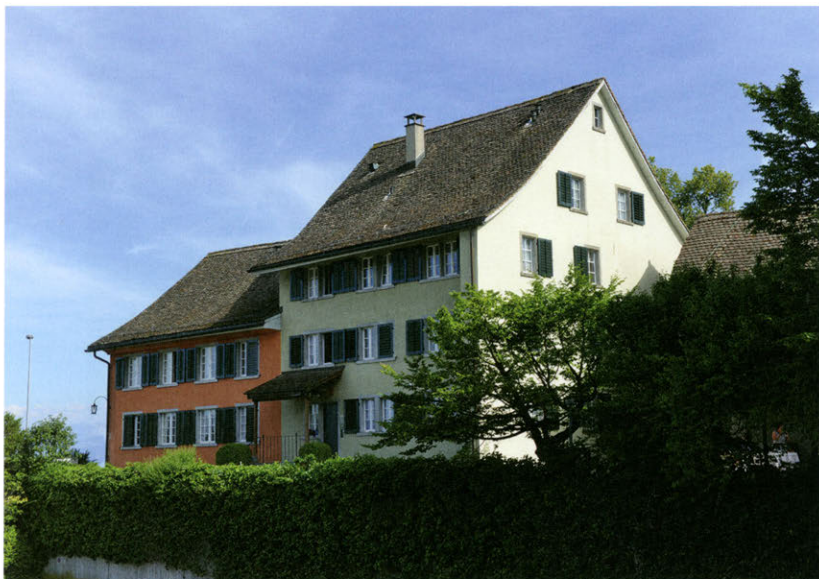
(Abb. 36) Rückseitige Ansicht auf Dorfstrasse 80 und 82, 2015
