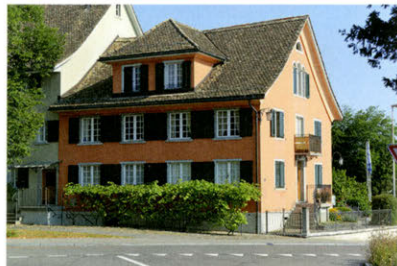
(Abb. 32) Ansicht auf die Rückseite der Häusergruppe Dorfstrasse 84 und 82, 2015
