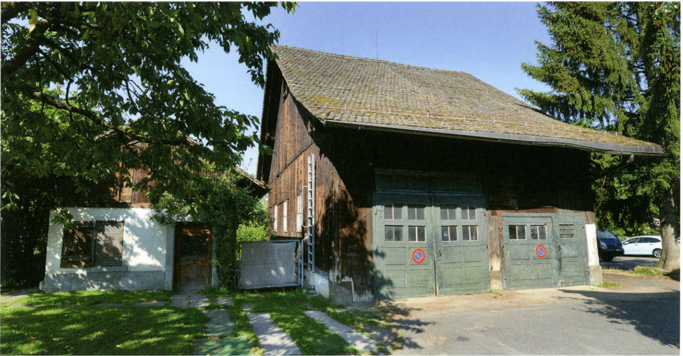
(Abb. 50) Waschhaus und Scheune von Südosten, 2015
