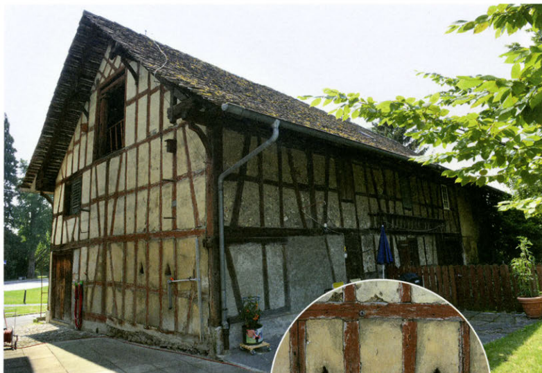
(Abb. 41) Ansicht der rückseitigen Scheune, 2015
