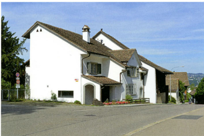
(Abb. 22) Ansicht auf die Baugruppe des Sigristenhauses von Westen, 2015
