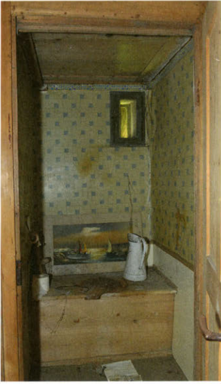
(Abb. 44) Ehemaliger Abort mit hölzerner Abtrittablage, 2015
