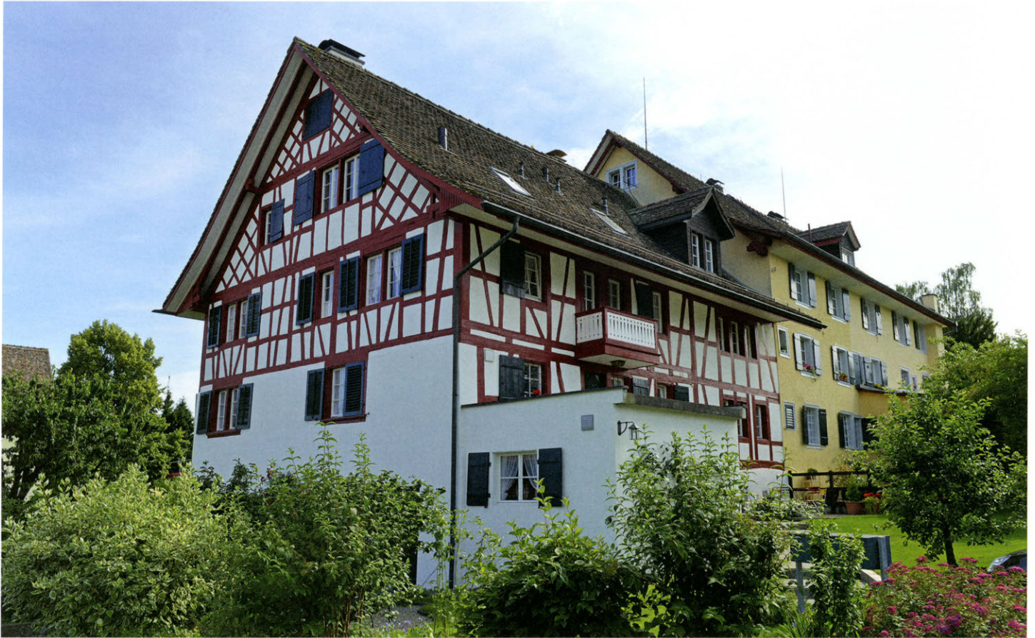
(Abb. 17) Dorfstrasse 116, Ansicht der Giebel- und Rückseite, 2015
