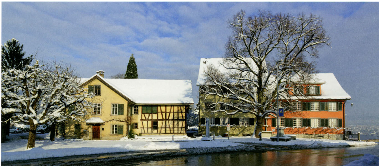
(Abb. 34) Ansicht auf die Häusergruppe Dorfstrasse 84, 82 und 80 von Süden, 2014
