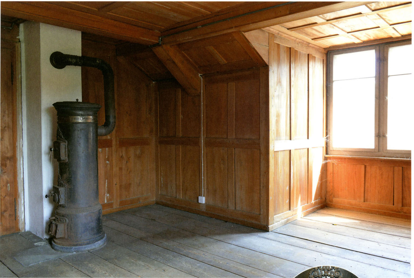
(Abb. 43) Stube im Obergeschoss mit Holzofen, 2015
