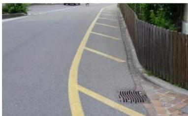
Durch die Markierung von Fussgängerlängsstreifen können fehlende Fussgängerverbindungen temporär behoben werden. Die Breite des Streifens wird auf die erwartete Fussgängerzahl angepasst. In der Regel muss der Fussgängerraum gegenüber der Fahrbahn mit Pollern abgegrenzt werden. Dies ist für den Unterhalt negativ. Die Bewilligung wird von der Kantonspolizei erteilt. In Tempo-30-Zonen werden grundsätzlich keine Fussgängerlängsstreifen bewilligt.
