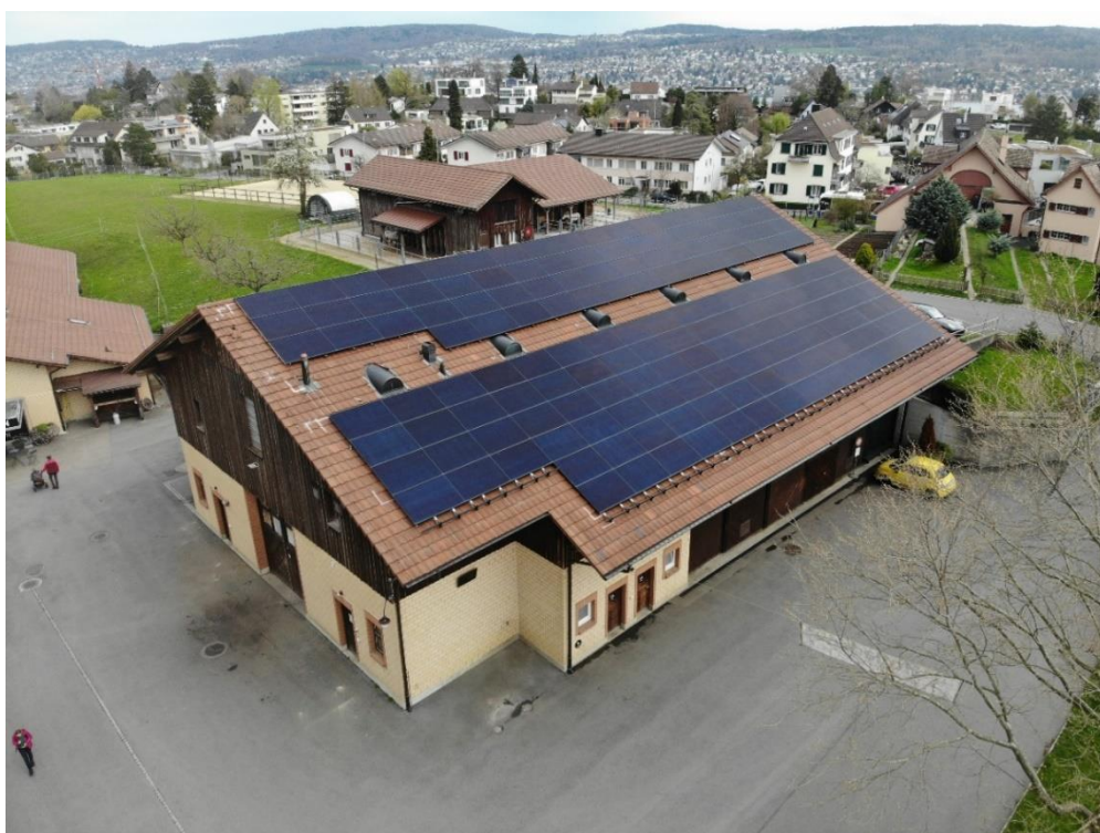
Remise mit der neuen Photovoltaikanlage. Sie hat einen Eigenverbrauchsgrad von rund 57 %.
